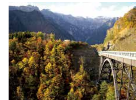
北アルプス大橋
