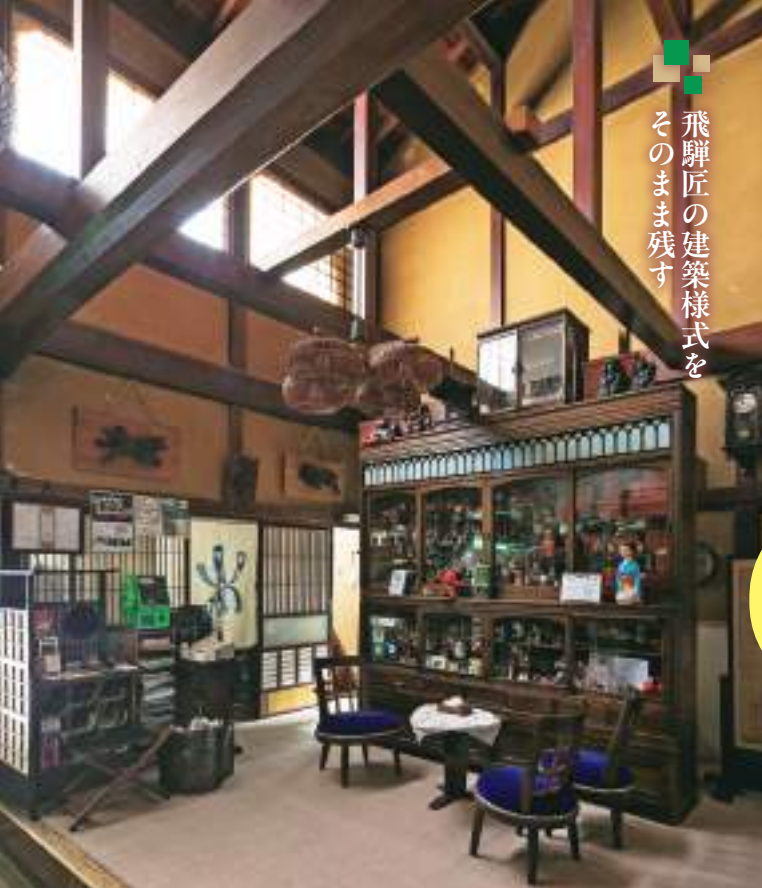
◀ 高山町屋造りの特徴である吹き抜けの梁組が見られる
