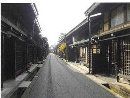
屋台が通りやすうにと電柱を撤去 (恵比須台組町並み保存会区域)
